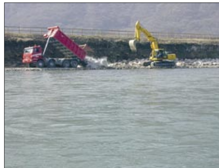
Dammverstärkungen durch Blocksteinschüttungen bei Pfatten Foto: Provinz Bz
