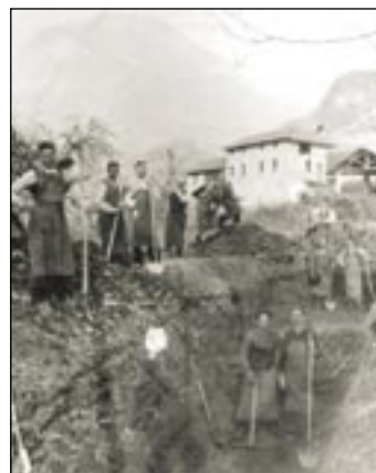
Grabenaushubarbeiten bei Salurn
