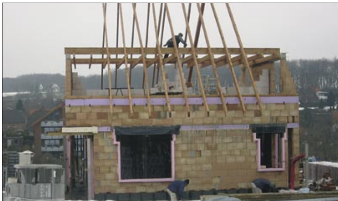
Massivbau mit Ziegeln ist nicht überholt
