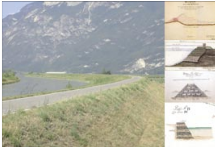
Wer denkt schon beim Radfahren daran, dass die Etsch in Südtirol von Meran bis Salurn fast durchgehend links und rechts mit bis zu 8 m hohen Dämmen eingedeicht ist? Foto: Provinz Bz und Kurt Werthl
