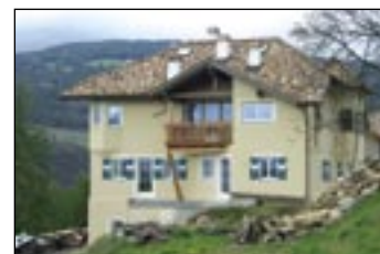
Wohnhaus in Holzplattenbauweise mit verputzter Fassade
