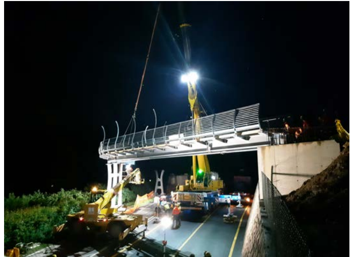
^ Aufwendige Montage der Radbrücken in Kalditsch mitten in der Nacht
